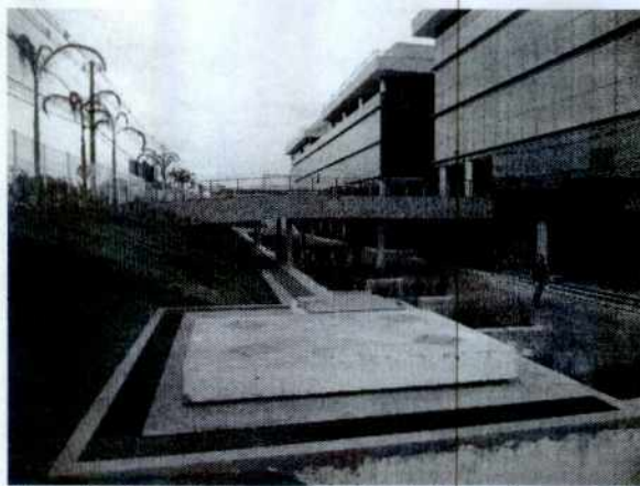
Figura 5: Vista dos taludes e área de galeria com lojas voltadas para via do SIA no "Semienterrado". Fonte: Assessoria Técnica - Vistoria em 2/6/2016
