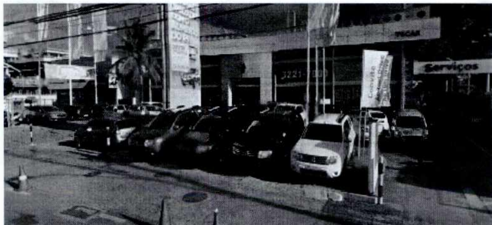
Figura 16: Exemplo de tratamento do terreno em relação a via do SIA, onde se visualiza a unidade dos lotes. / Fonte: Assessoria Técnica - Vistoria em 2/6/2016.
